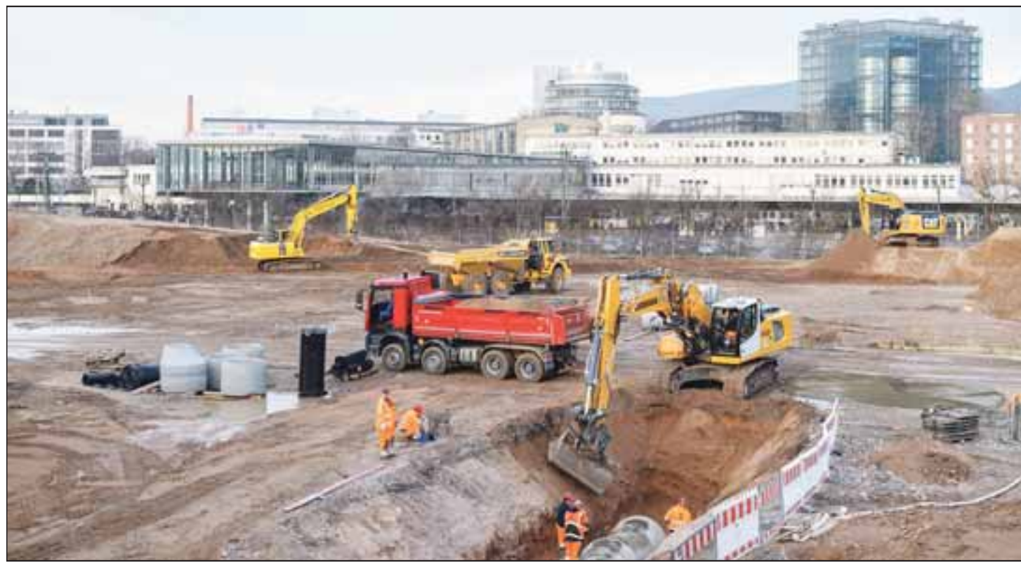
Der Querbahnsteig des Hauptbahnhofs wird verlängert und führt auf den künftigen Bahnhofplatz Süd. Foto: Philipp Rothe
