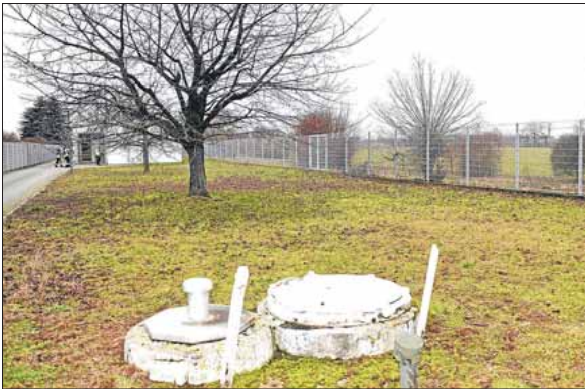
Die blaue Verfärbung des Trinkwassers stammt aus dem Wasserwerk Entensee im Handschuhsheimer Feld. Mittlerweile wurde es vom Netz genommen; andere Tiefbrunnen versorgen jetzt die Bürger. Foto: Katzenberger-Ruf
